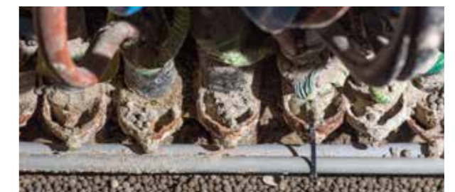
Controle montage afgaande kabel op deugdelijke klemverbindingen
